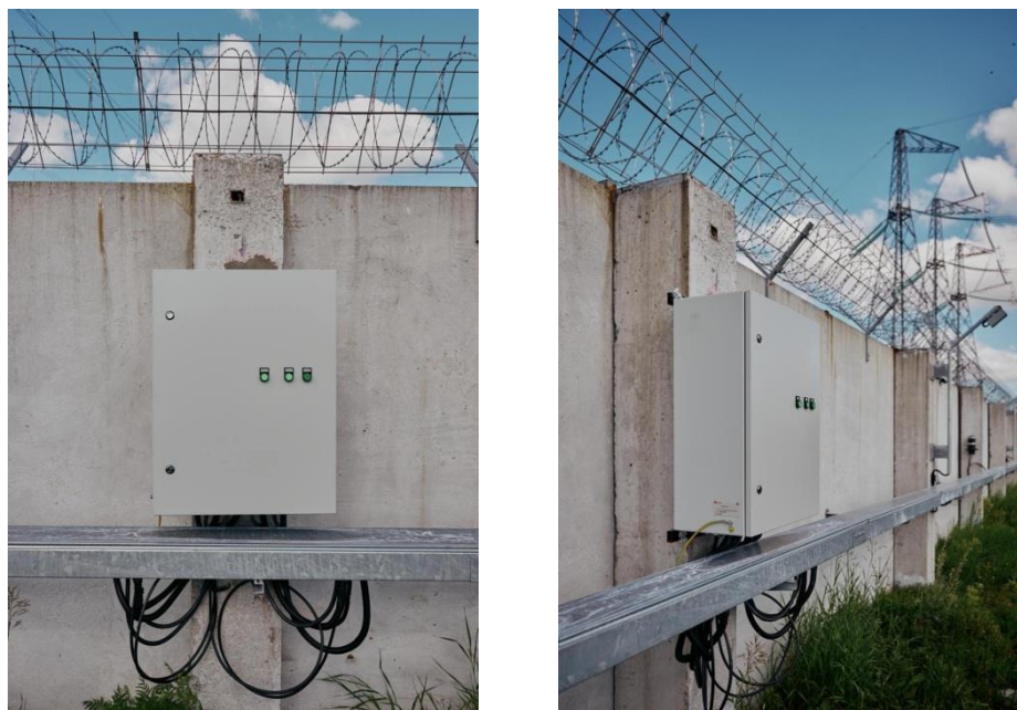
Рисунок 2.1 - Пример установки шкафа на ж/б забор
